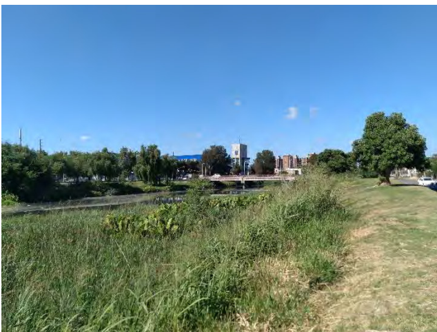
Figura 25: Canal Sarandí hacia puente de calle Carlos Gardel
