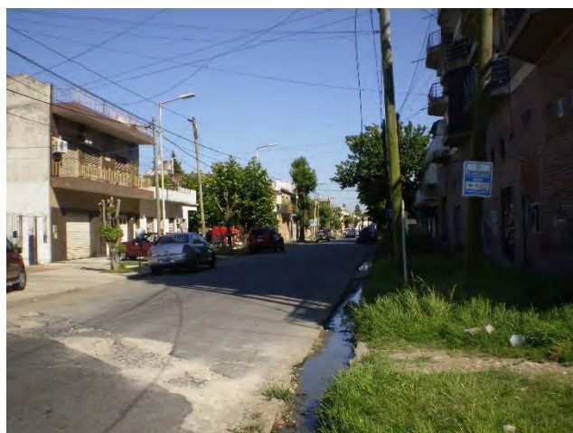
Figura 08: Estrada y Debenedetti, hacia Cucha Cucha. Cordón cuneta colmatado (derecho).
