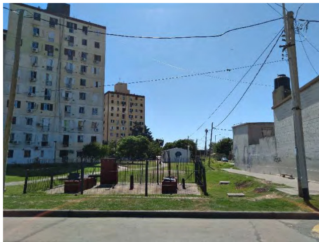
Figura 42: Vista de pozo cloacal existente y senda peatonal a sus lados (calle Cucha Cucha, senda derecha)
