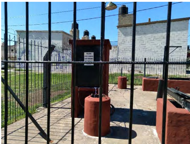
Figura 41: Detalle pozo cloacal
